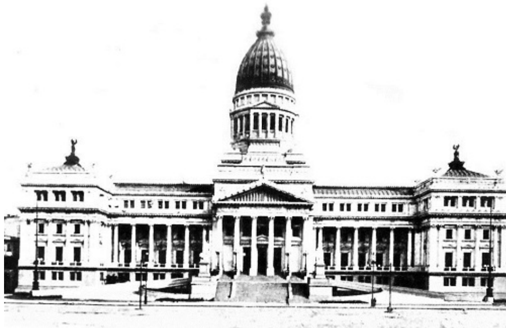
Figura 4. Palacio del Congreso de la Nación Argentina, Buenos Aires. Fachada principal hacia Av. Entre Ríos., col. a., ca. 1918
